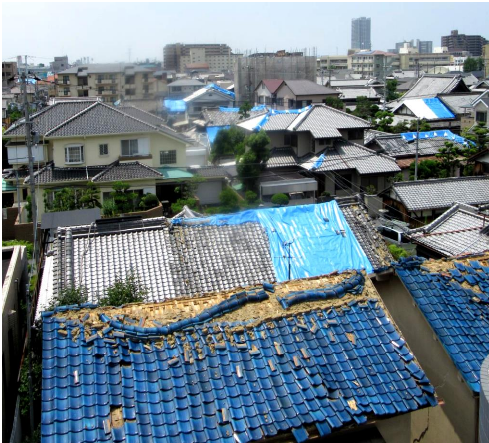
屋根瓦に被害があった住宅 （高槻市）
