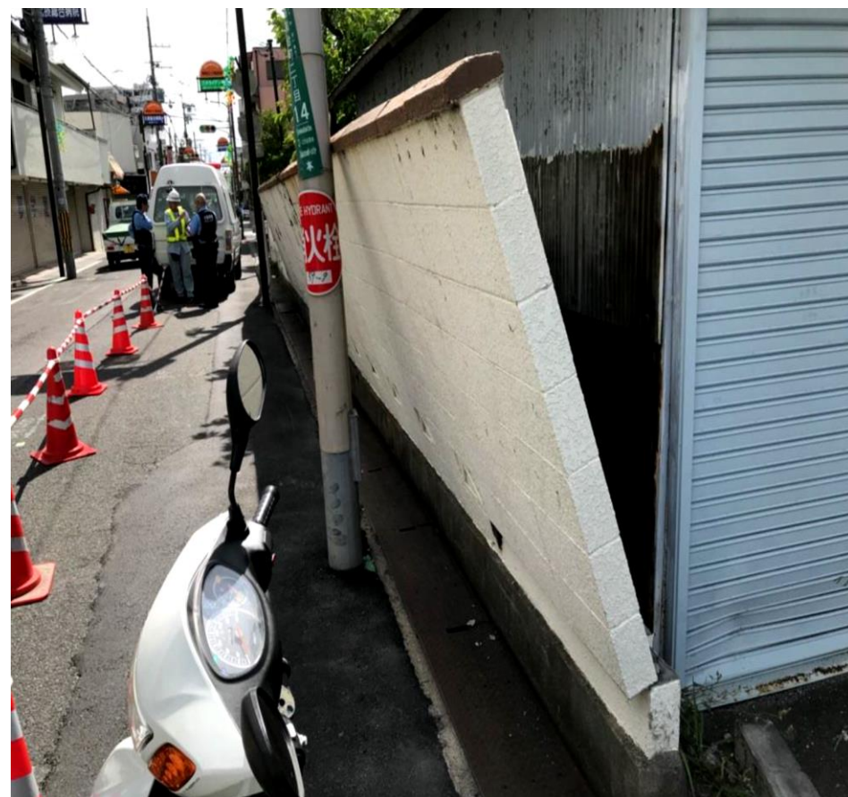
転倒したブロック塀 （高槻市）
