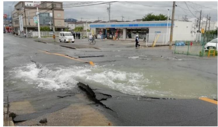
水道管が破断して水が噴き出した道路
