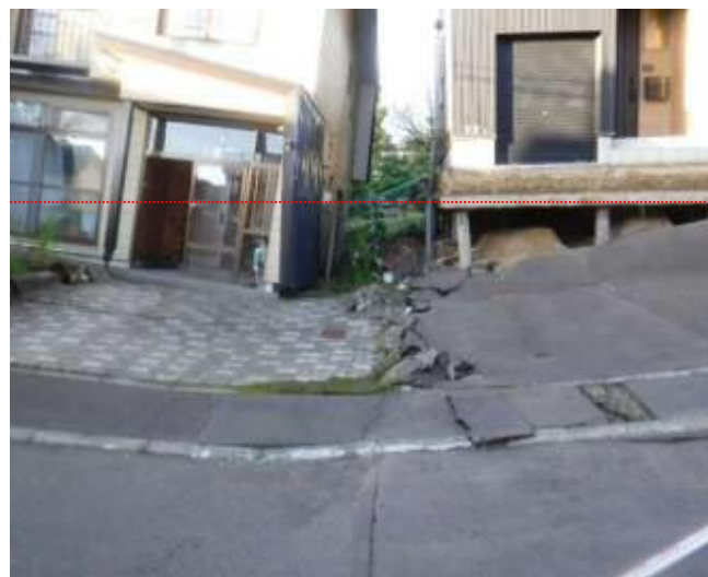
周辺より傾く家屋と道路に亀裂 （北海道胆振東部地震：札幌市清田区）
