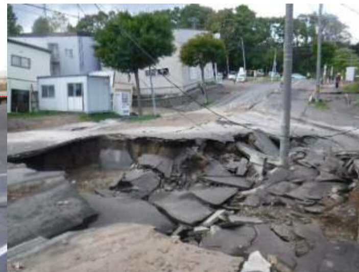
周辺より傾く家屋と道路に亀裂 （北海道胆振東部地震：札幌市清田区）
